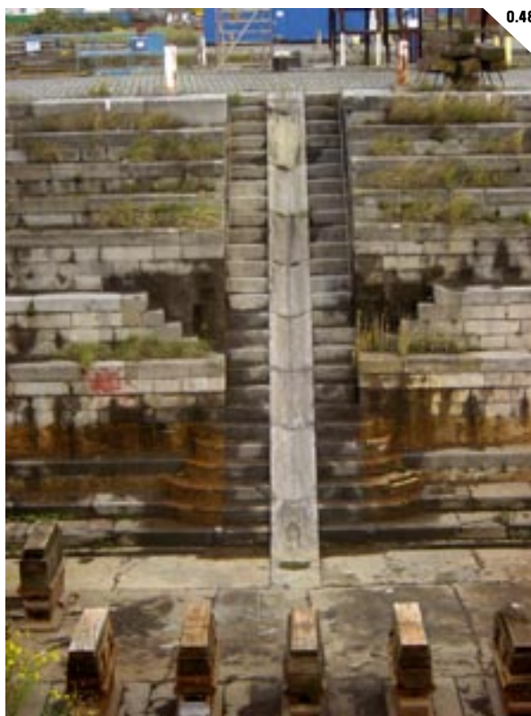
0.48 // De infrastructuur van de droogdokken is ook een beschermd monument.
